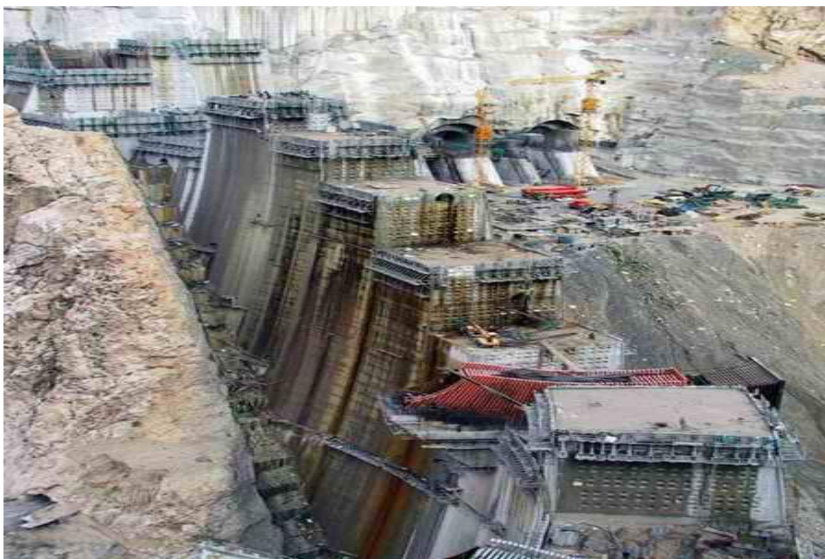
نمایی از سد کارون ۳ در حال ساخت
